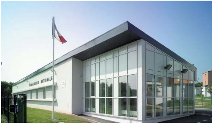
GENDARMERIE - La Chapelle sur Erdre Architecte : Agence 6 ème Rue
