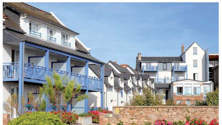
RÉSIDENCE LES BAINS - Trégastel
