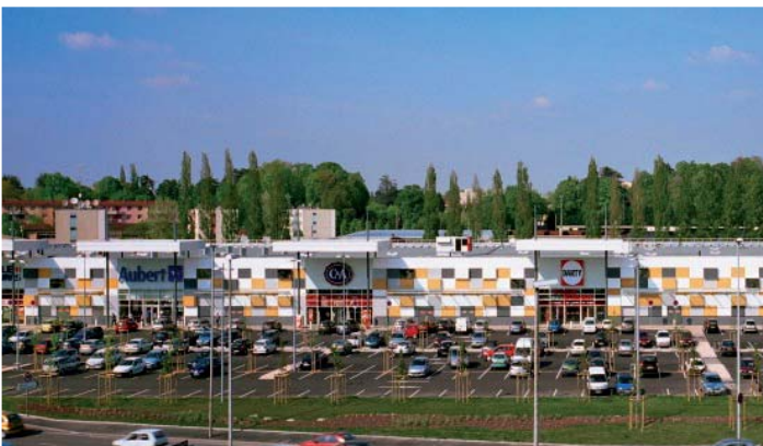
CARREFOUR DE L'EUROPE - Bourg-en-Bresse Architecte : P. Barillot
